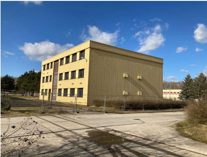
Kraftwerk Thierbach, Sozialgebäude, Blick von Süden Fotograf/Urheber: Nils Schinker
