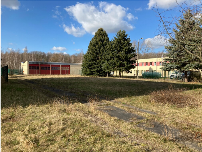
Kraftwerk Thierbach, Garagen und Werkstattgebäude, Blick von Südost Fotograf/Urheber: Josephine Dressler
