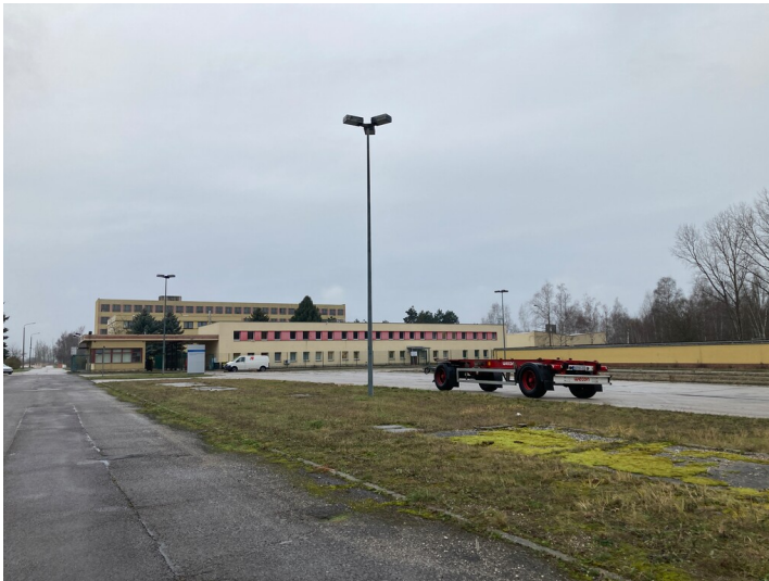
Kraftwerk Thierbach, Motorrad- und Fahrradunterstand sowie Bushaltestelle, Blick von Osten Fotograf/Urheber: Nils Schinker
