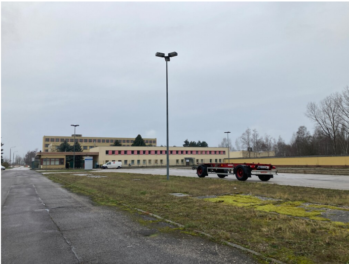
Kraftwerk Thierbach, Motorrad- und Fahrradunterstand sowie Bushaltestelle, Blick von Osten Fotograf/Urheber: Nils Schinker
