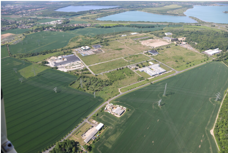
Kraftwerk Thierbach, Schrägluftbild von Südost Fotograf/Urheber: Ronald Heynowski
