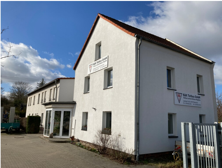
Grube und Braunkohlenwerk Gewerkschaft Margaretha, Arbeiterwohnhaus, Blick von Nordwest Fotograf/Urheber: Nils Schinker
