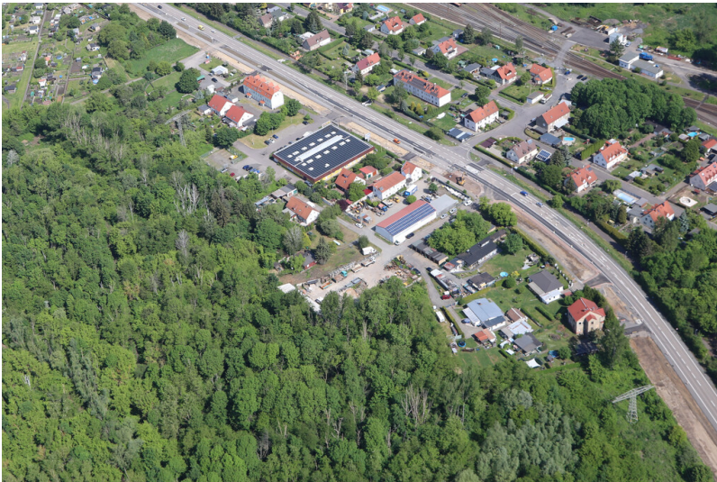
Ehemaliges Braunkohlenwerk Gewerkschaft Margaretha, Schrägluftbild von Süden Fotograf/Urheber: Ronald Heynowski
