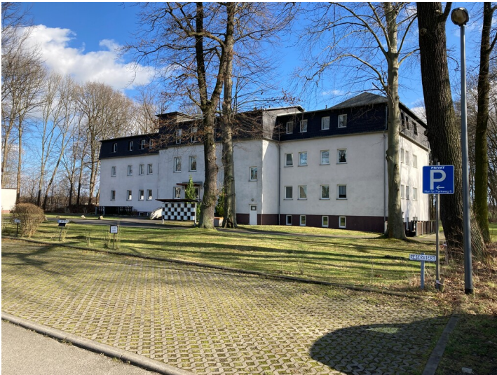
Frühere Kinderkrippe "Lilo Herrmann" des VEB Kombinat Espenhain, heute Mehrfamilienwohnhaus; Blick von Westen Fotograf/Urheber: Nils Schinker
