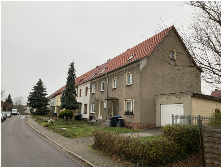
Bergarbeitersiedlung Kitzscher, Reihenhauszeile an der Kurt-Schönfelder-Straße, Blick nach Westen Fotograf/Urheber: Nils Schinker
