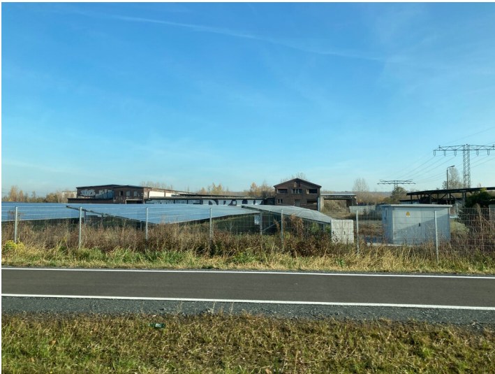
frühere Wasseraufbereitungsanlage; Blick von Südwest Fotograf/Urheber: Nils Schinker
