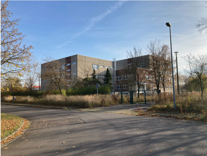
Schulgebäude in Großtafelbauweise der Typenreihe SR 80 Leipzig; Blick von Südwest Fotograf/Urheber: Nils Schinker
