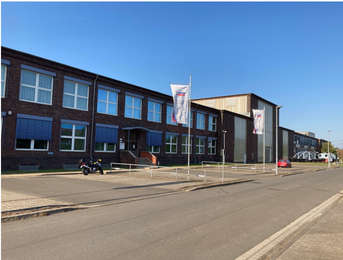
Teil der Objektgruppe ehemaliges Braunkohlenveredelungswerk Espenhain (30100035), Gebäudekomplex der Zentralwerkstatt mit drei Kranbahnhallen, Verwaltungs- und Schulungsräumen Fotograf/Urheber: Nils Schinker
