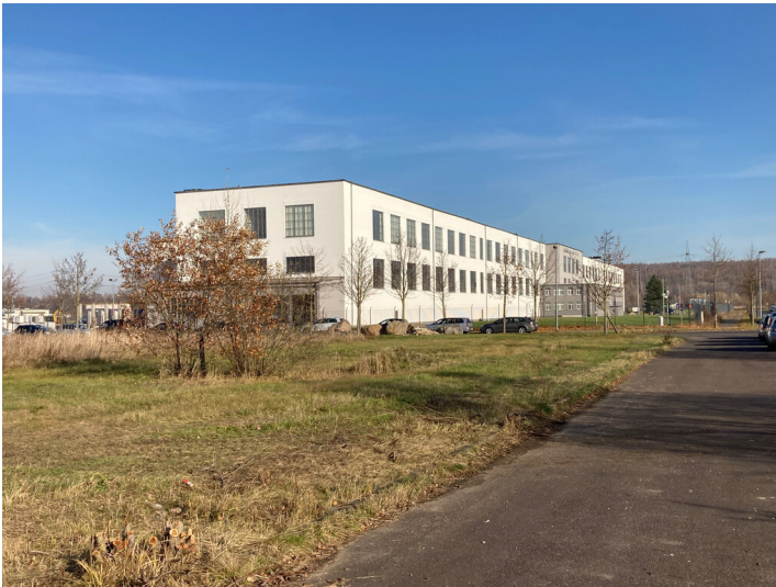
Schaltwarte, Blick von Süden Fotograf/Urheber: Nils Schinker
