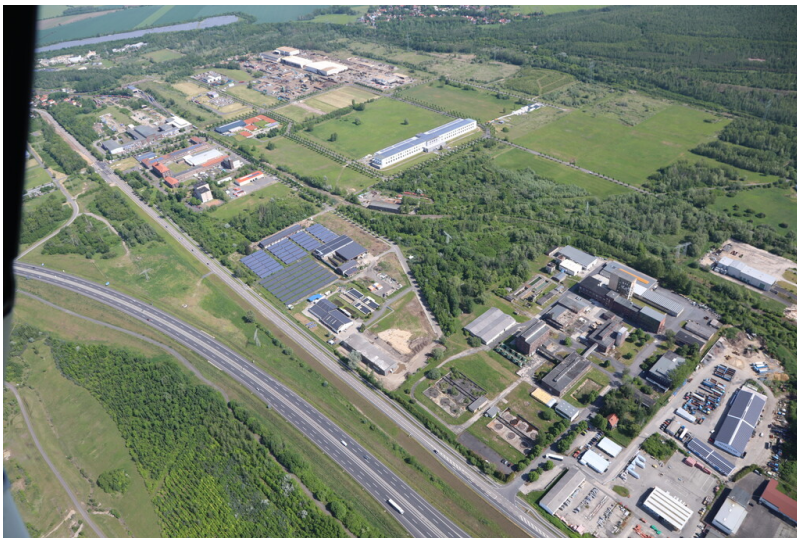
Braunkohlenveredlungswerk Espenhain, Schrägluftbild, Blick nach Nordost Fotograf/Urheber: Ronald Heynowski
