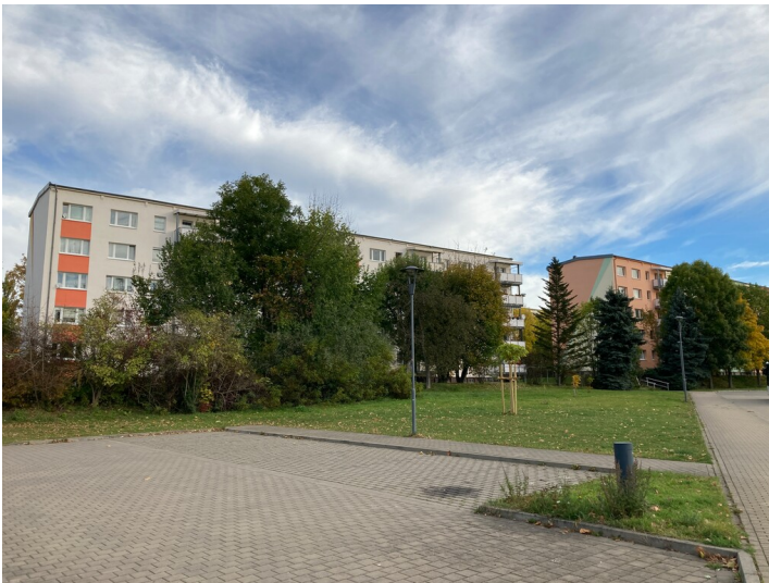
Bergarbeitersiedlung Kitzscher, Wohnkomplex Kitzscher-Nord, Birkenstraße, Blick von Südwest Fotograf/Urheber: Nils Schinker
