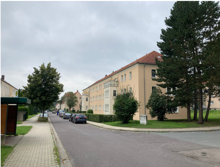
Bergarbeitersiedlung Kitzscher, Mehrfamilienwohnhäuser an der Robert-Koch-Straße, Blick nach Nordwest Fotograf/Urheber: Nils Schinker
