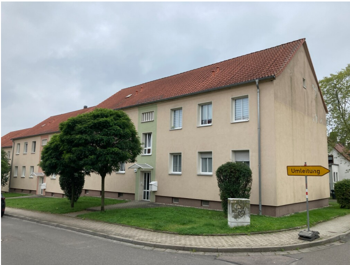
Bergarbeitersiedlung Kitzscher, Mehrfamilienhauszeile an der Nordstraße, Blick nach Südwest Fotograf/Urheber: Nils Schinker
