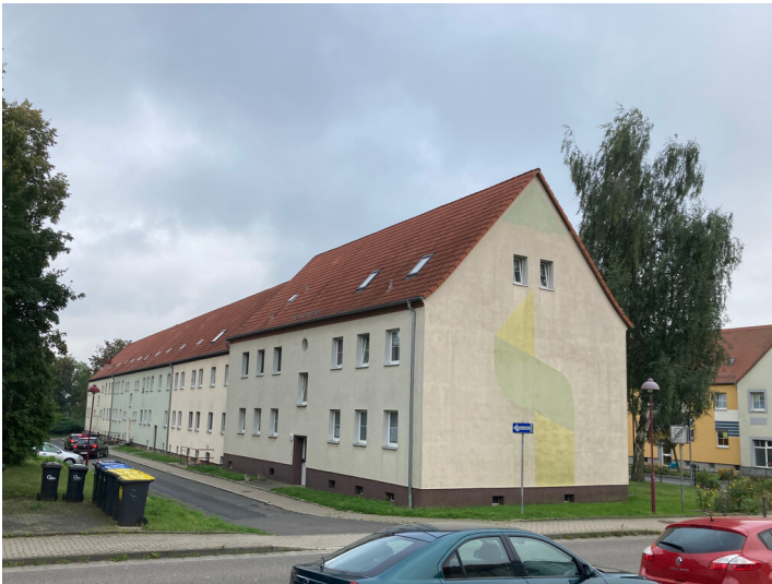
Bergarbeitersiedlung Kitzsche, Mehrfamilienhäuser an der Trageser Straße, Blick nach Südwest Fotograf/Urheber: Nils Schinker
