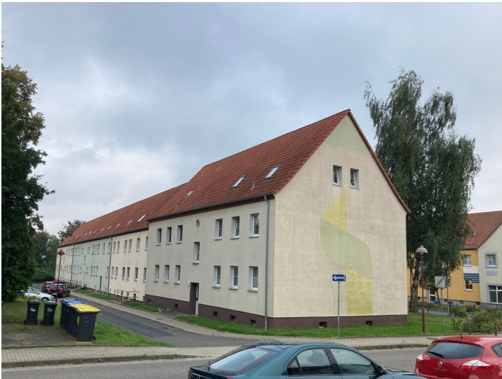
Bergarbeitersiedlung Kitzsche, Mehrfamilienhäuser an der Trageser Straße, Blick nach Südwest Fotograf/Urheber: Nils Schinker
