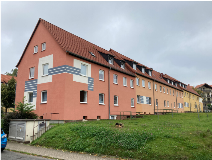
Bergarbeitersiedlung Kitzscher, Mehrfamilienhäuser an der Trageser Straße, Blick nach Südost Fotograf/Urheber: Nils Schinker
