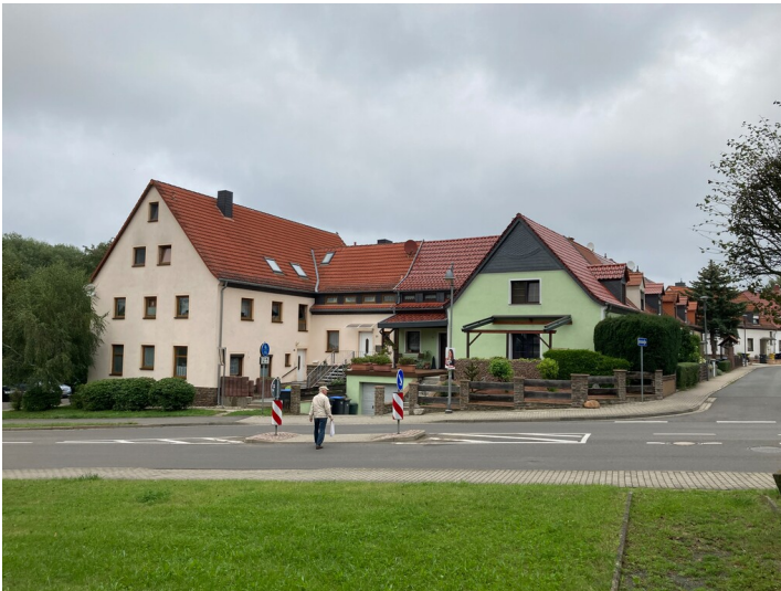
Bergarbeitersiedlung Kitzscher, Reihenhauszeile und Mehrfamilienhaus an der Karl-Liebknecht-Straße, Blick von Südost Fotograf/Urheber: Nils Schinker
