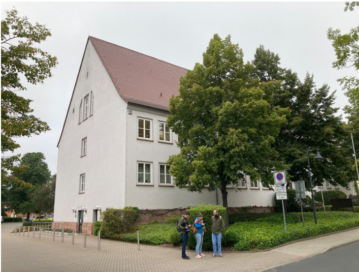
Bergarbeitersiedlung Kitzscher, Rathaus, Blick von Südost Fotograf/Urheber: Nils Schinker
