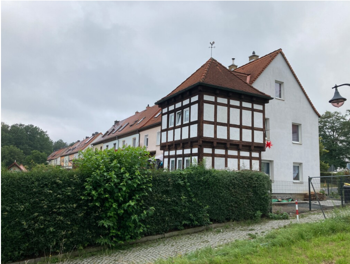
Bergarbeitersiedlung Kitzscher, Reihenhauszeile am Schwarzholzweg, Blick nach Nordwest Fotograf/Urheber: Nils Schinker
