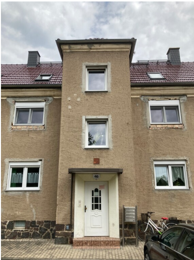
Städtebauliches Ensemble aus Mehr- und Einfamilienreihenhäusern, Eingangsdetail Fotograf/Urheber: Nils Schinker
