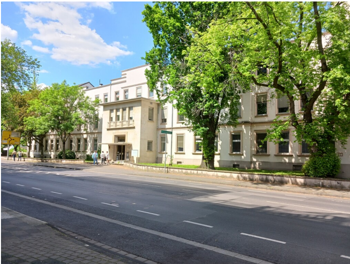
Verwaltung Roddergrube, Brühl, Blick von Südosten auf die Hauptfassade, 19.5.2023 Fotograf/Urheber: Dr. Alexander Kierdorf
