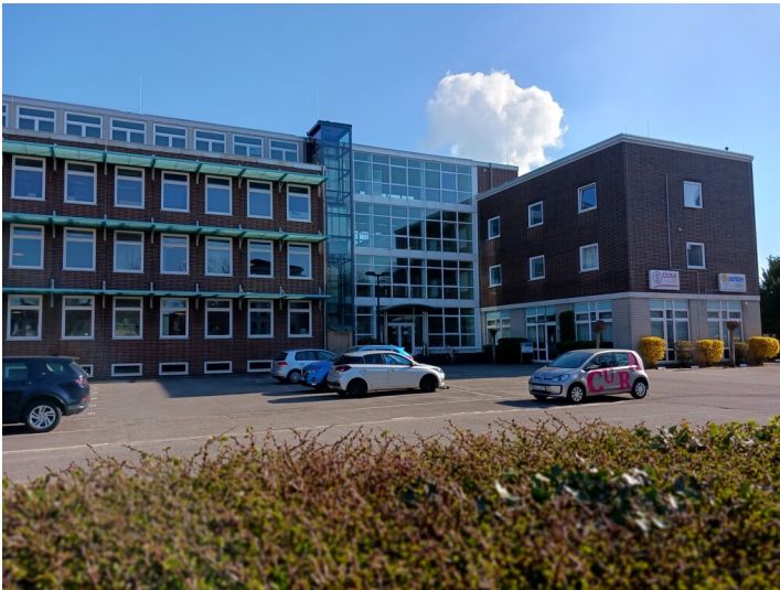
Ehem. BIAG-Verwaltung, Eschweiler, Blick von Süden auf Haupttreppenhaus, 5.4.2023 Fotograf/Urheber: Dr. Alexander Kierdorf
