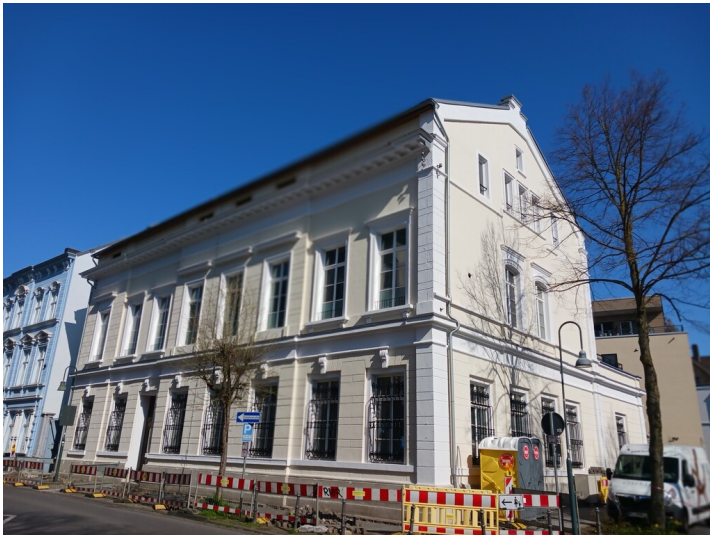
Eschweiler, Kirschenhof/Ehem. Verwaltung Zukunft, Blick von Südosten, 5.4.2023 Fotograf/Urheber: Dr. Alexander Kierdorf
