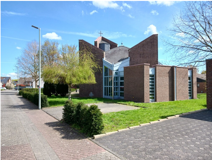
Umsiedlung Pattern, Matthäus-Kapelle von Süden; Foto: 16.04.2023 Fotograf/Urheber: Dr. Alexander Kierdorf
