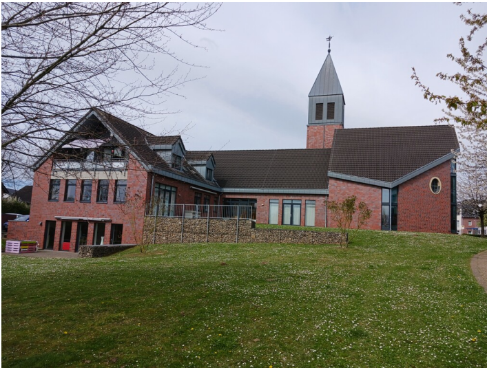
Umsiedlung Otzenrath-Spenrath, Ev. Gemeindezentrum, Blick von Südosten, 15.4.2023 Fotograf/Urheber: Dr. Alexander Kierdorf
