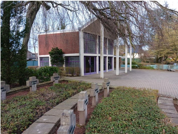
Habbelrath, Friedhof mit Trauerhalle, Blick von Westen, 28.3.2023 Fotograf/Urheber: Dr. Alexander Kierdorf
