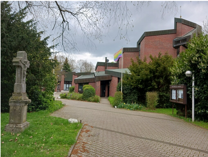
Neu-Elfgen, Kath. Pfarrkirche St. Georg, Ansicht von Norden, 15.4.2023 Fotograf/Urheber: Dr. Alexander Kierdorf
