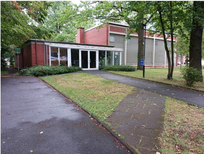
Kerpen-Neu-Bottenbroich, Mehrzweckhalle mit Foyer, Blick von Süden, 15.7.2023 Fotograf/Urheber: Dr. Alexander Kierdorf
