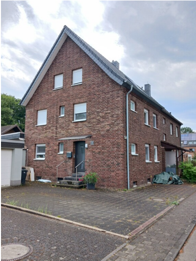
Kerpen-Neu-Bottenbroich, Haustyp (Buchenweg 16), 15.7.2023 Fotograf/Urheber: Dr. Alexander Kierdorf
