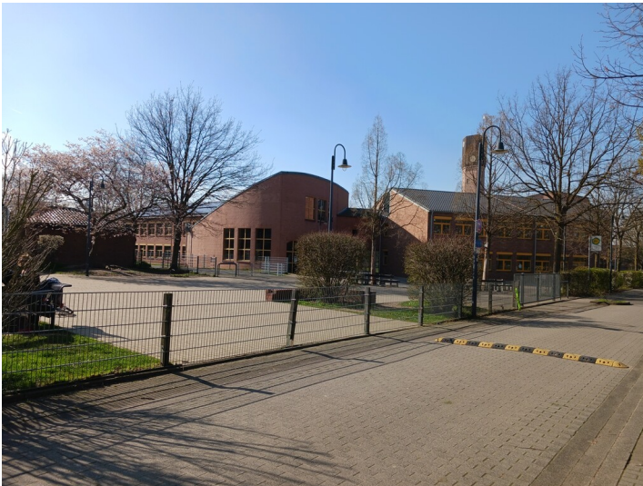
Inden/Altdorf, Schule, Außenfront von Nordosten, 5.4.2023 Fotograf/Urheber: Dr. Alexander Kierdorf
