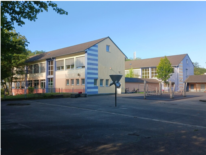
Umsiedlung Berrenrath, Grundschule, Blick von Westen, 21.9.2022 Fotograf/Urheber: Dr. Alexander Kierdorf
