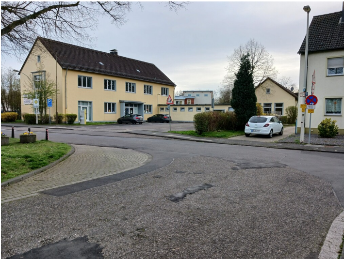
Frechen-Grefrath, Schule, Blick von Norden, 28.3.2023 Fotograf/Urheber: Dr. Alexander Kierdorf
