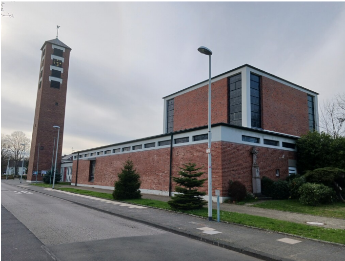
Frechen-Grefrath, Kirche Hl. Geist, Ansicht von Osten, 28.3.2023 Fotograf/Urheber: Dr. Alexander Kierdorf
