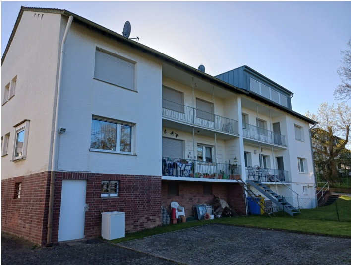
Zülpich, Siedlung Geicher Gasse, Mehrfamilienhaus, Gartenseite (Norden), 14.4.2023 Fotograf/Urheber: Dr. Alexander Kierdorf
