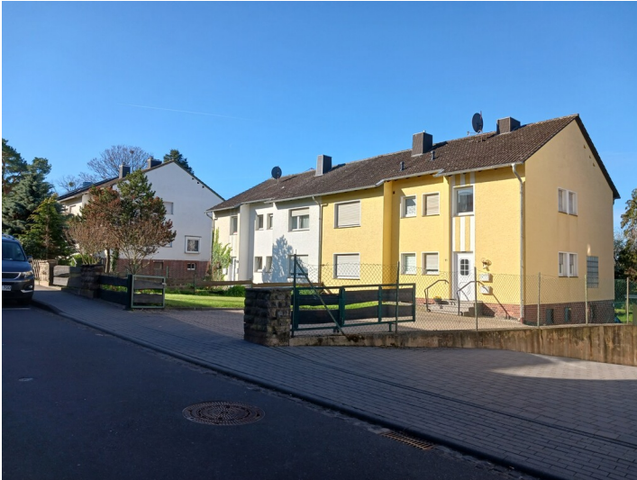
Zülpich, Siedlung Geicher Gasse, Etagenwohnhäuser, Straßenseite (Süden), 14.4.2023 Fotograf/Urheber: Dr. Alexander Kierdorf
