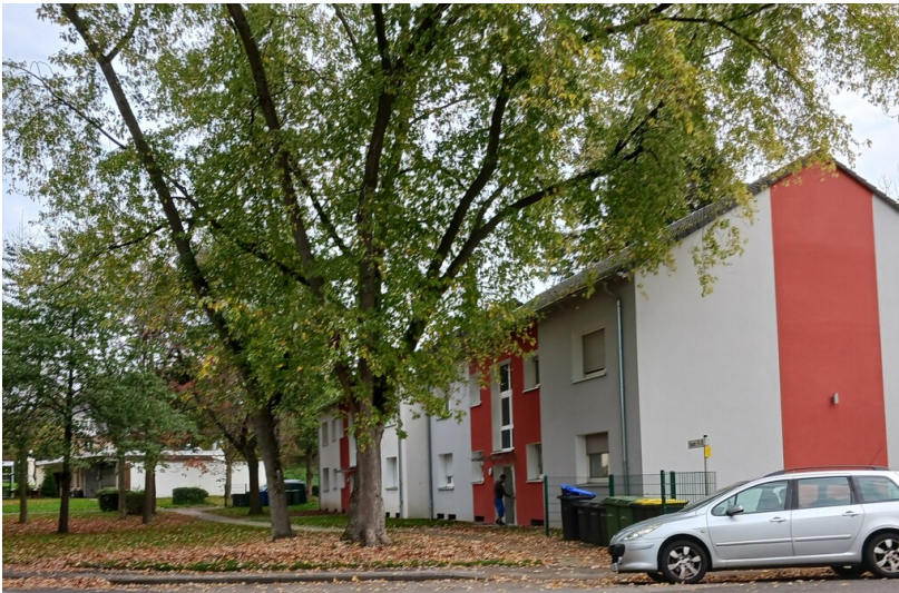
Lucherberg, Siedlung An der Kippe, Typ 7: Mehrfamilienhaus, 5.11.2022 Fotograf/Urheber: Dr. Alexander Kierdorf
