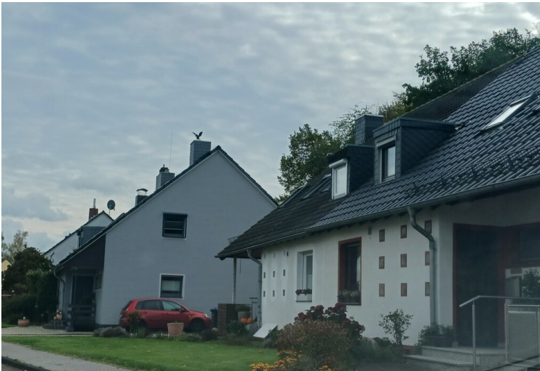
Lucherberg, Siedlung An der Kippe, Talstraße, Typ 4, 5.11.2023 Fotograf/Urheber: Dr. Alexander Kierdorf
