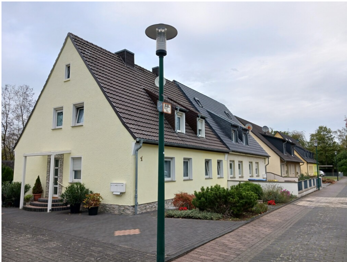
Hürth, Werkssiedlung Berrenrath, Haustyp 4, 3.11.2022 Fotograf/Urheber: Dr. Alexander Kierdorf
