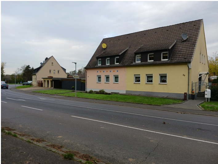
Hürth, Werksiedlung Berrenrath, Haustyp 3, 3.11.2022 Fotograf/Urheber: Dr. Alexander Kierdorf
