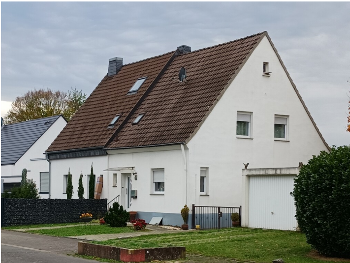
Hürth, Siedlung Berrenrath, Haustyp 2, 3.11.2022 Fotograf/Urheber: Dr. Alexander Kierdorf
