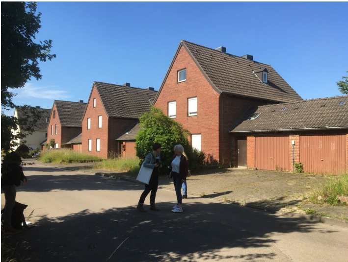
Mertzenich-Morschenich, Werkssiedlung Union 103, Unterstraße, 2.6.2022 Fotograf/Urheber: Dr. Alexander Kierdorf
