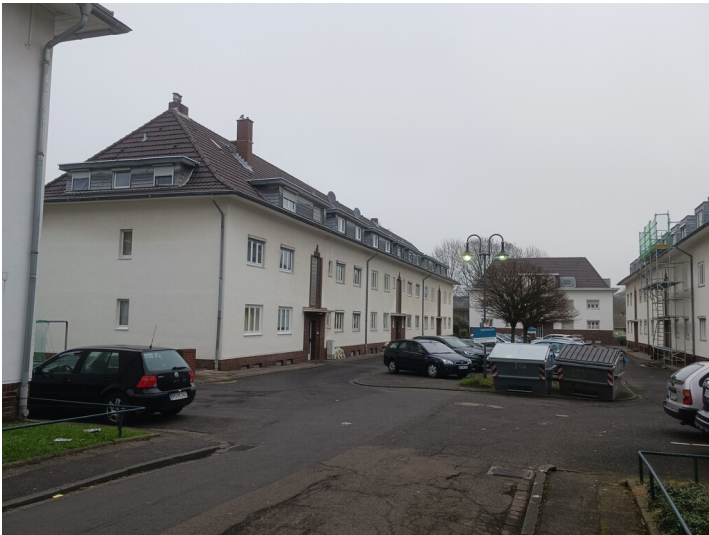
Hürth_Clementinenhof, Innenhof, Blick nach Nordosten, 25.1.2023 Fotograf/Urheber: Dr. Alexander Kierdorf
