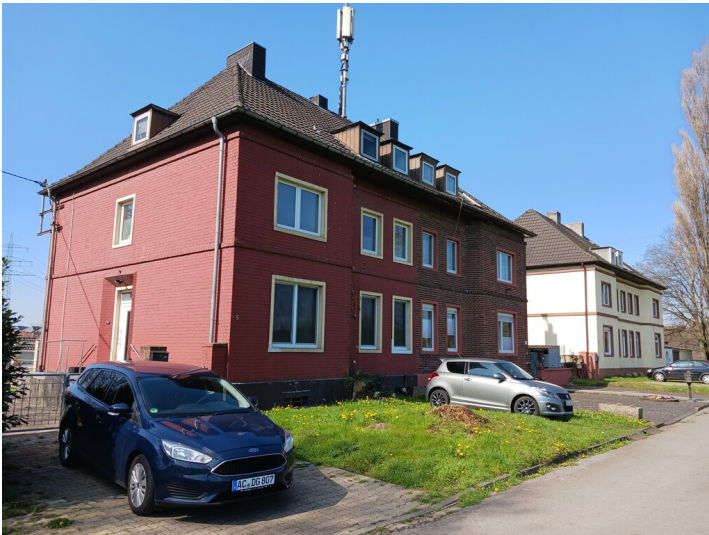
Eschweiler-Weisweiler, Siedlung Langgasse, Blick von Osten, 5.4.2023 Fotograf/Urheber: Dr. Alexander Kierdorf
