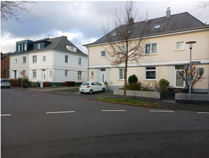
Hürth, Siedlung Marienbornweg, Blick von Süden, 3.1.2023 Fotograf/Urheber: Dr. Alexander Kierdorf
