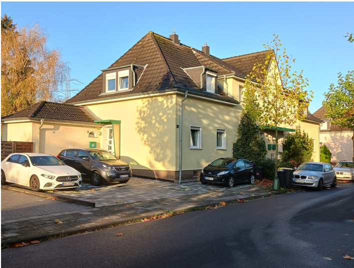
Oberaußem, Siedlung Kraftwerk, Typ 1: eingeschossiges Endhaus, 5.11.2023 Fotograf/Urheber: Dr. Alexander Kierdorf
