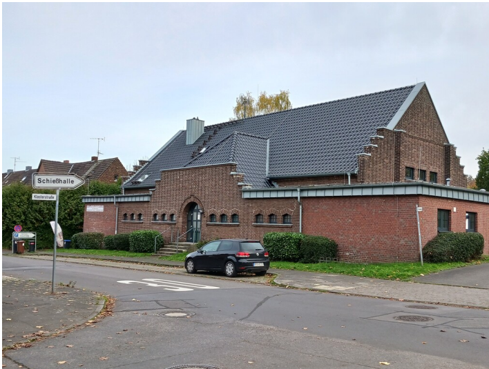
Brühl-Heide, Turnhalle, Blick von Westen, 31.10.2022 Fotograf/Urheber: Dr. Alexander Kierdorf
