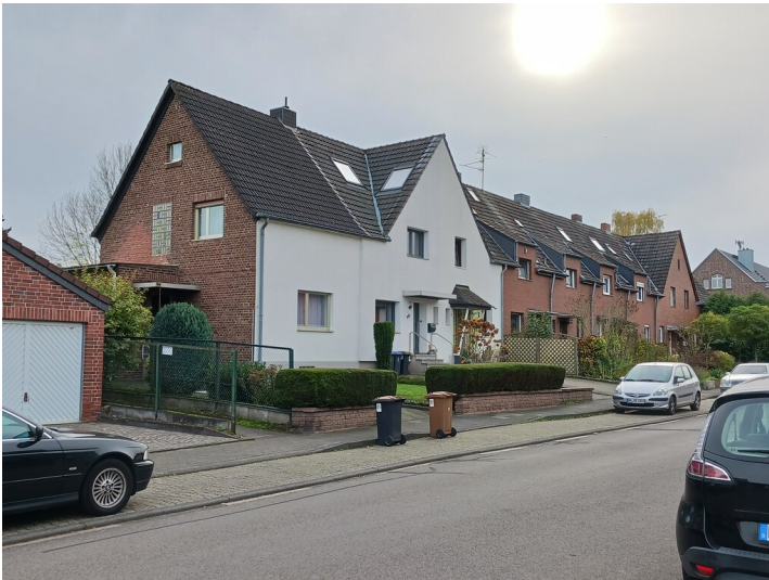
Brühl, Werksiedlung Heide, Typ4, Reihenhaus, Grubenstraße, 5.11.2022 Fotograf/Urheber: Dr. Alexander Kierdorf
